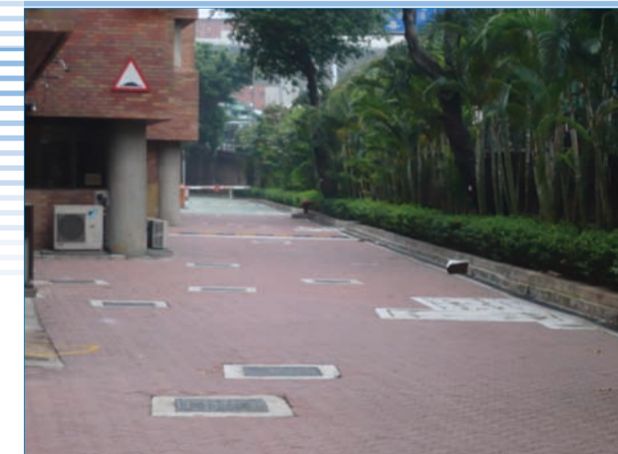
Application of Eco-Block: pavement in PolyU 環保再造磚已在理大校院內使用
